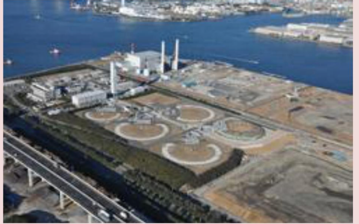
同じ発電方式で同規模のLNG火力発電所
